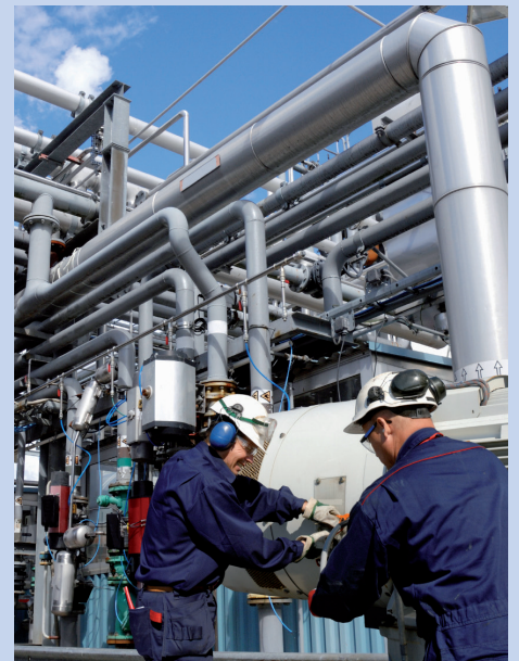
Schutzgas im Rohrleitungsbau
